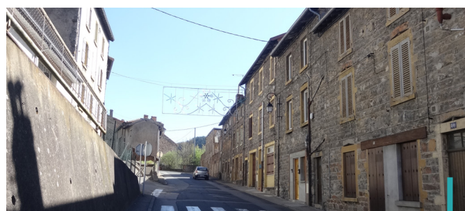
Rue Marie Couturier, état actuel avec un habitat très dégradé (quartier de la Claire) ©Cerema
