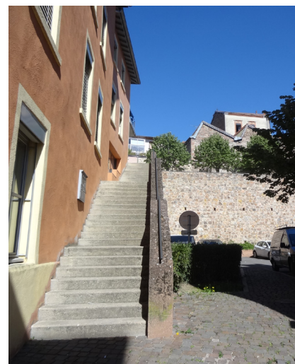
Traboule à prolonger, état actuel ©Cerema
