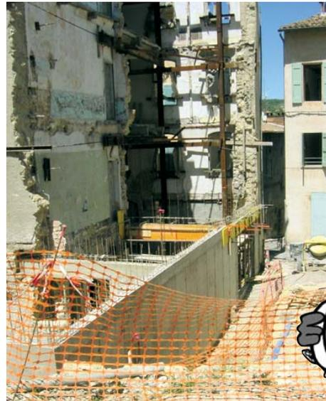
*L'entreprise a dû souvent travailler "à la petite cuillère", dégageant, confortant au fur et à mesure, avant de rebâtir par phases limitées...*
