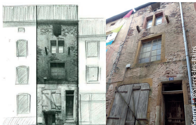
Exemple d'immeuble chandelle à rénover et restructurer
