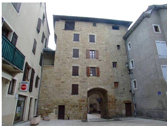
Réhabilitation de logements Porte du Théron
