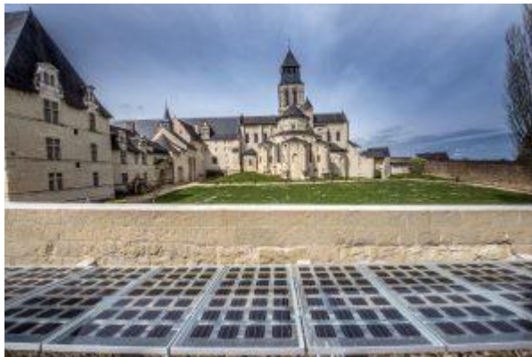
Photographie : Rôle Energies, article Panneaux solaires et proximité de monuments historiques, c'est maintenant possible et plus simple ! (2018)
