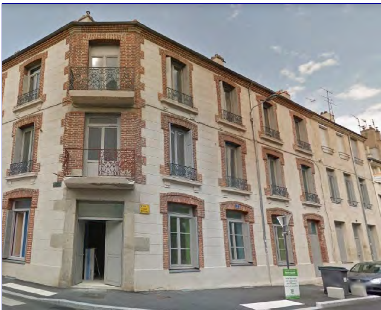
Vue de l'immeuble en rénovation. Crédit : Google
