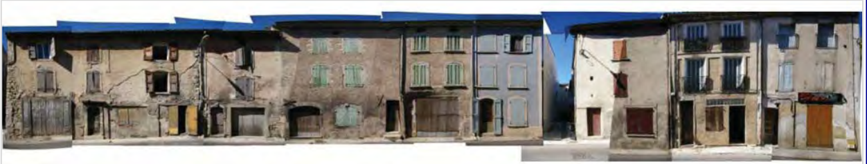
Figure 1 : Immeubles de l'îlot de la Bourgade en mauvais état.
