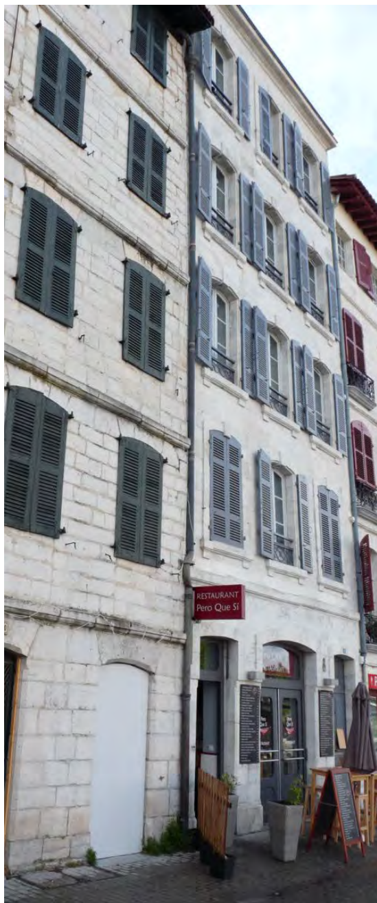
Immeubles du Quai Chao en cours de réhabilitation, crédit : Site de l'EPFL du Pays Basque
