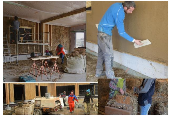
Chantiers participatifs à Quistinic © Bruded
