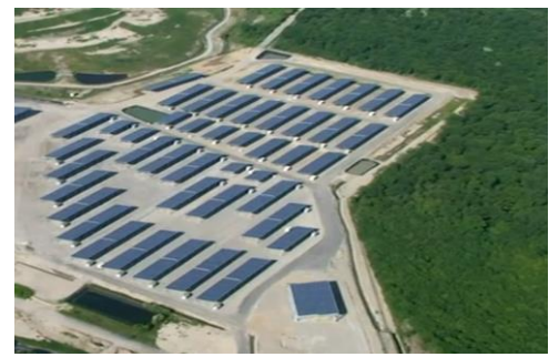
Centrale photovoltaïque à Ungersheim © Mairie d'Ungersheim
