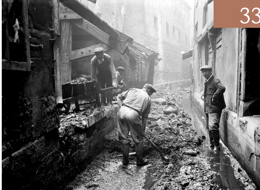
Travaux de curage du Crout, octobre 1948 © Archives municipales de Saint-Denis, 13 Fi 3514
