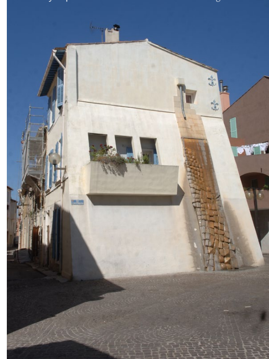
RHI mitoyen partiellement ouvert © Ville de Martigues
