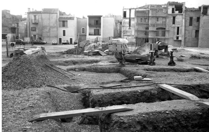
L'île RHI réfection des mitoyens © Ville de Martigues
