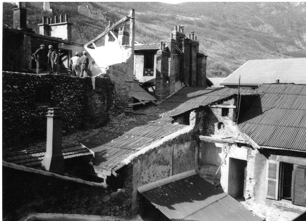
Toits Servan Un immeuble de la rue en cours de réhabilitation dans le quartier Très-Cloîtres © Ville de Grenoble
