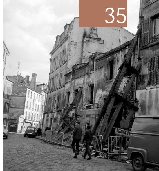
▲ La dégradation du bâti rue Jean ©Archives municipales de Saint-Denis
