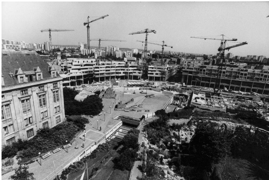
La construction des îlots de la ZAC vue depuis la Basilique, 1985 ©Archives municipales de Saint-Denis, 2 Fi 5/14, Gérard Monico
