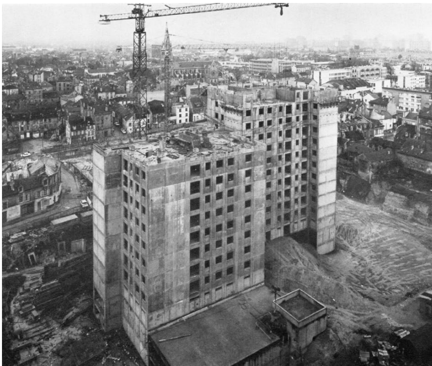
Opération en cours en décembre 1976
