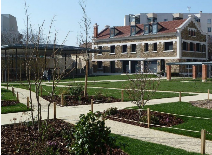
Rénovation Saint-Jean : jardin et fouilles
