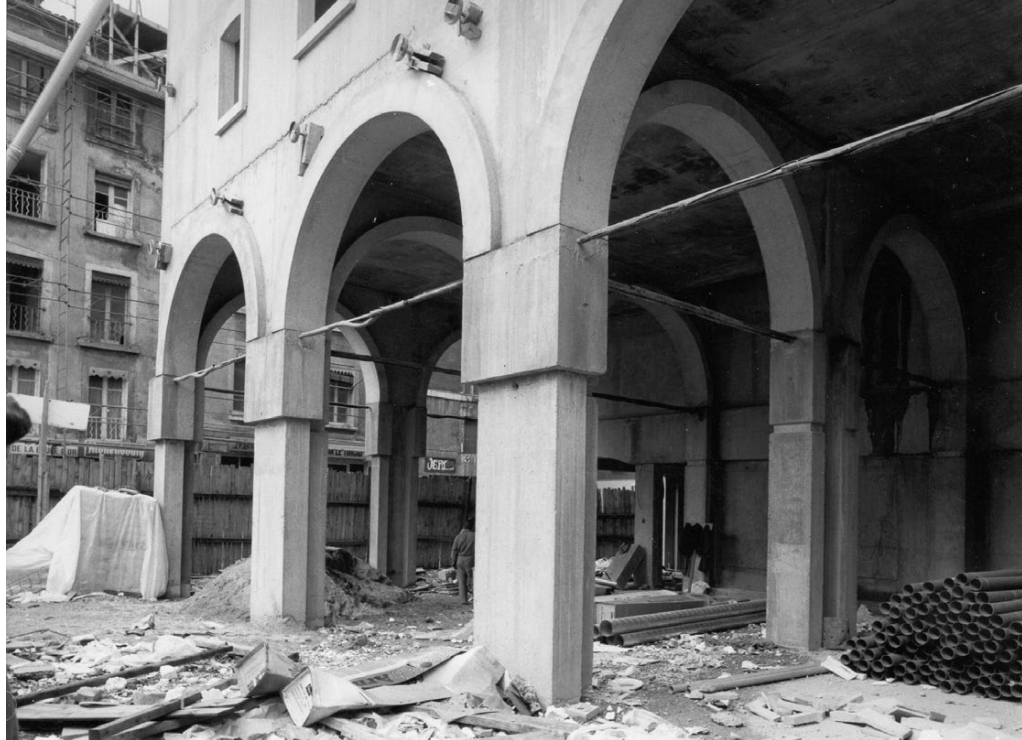
L'immeuble des Minimes, dans le quartier Très-Cloîtres, en cours de construction © Ville de Grenoble
