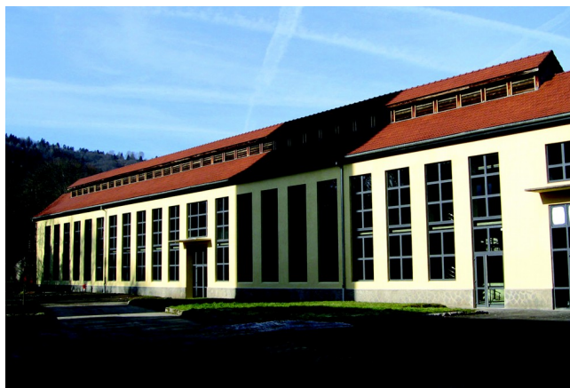
et après rénovation
