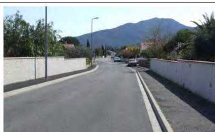
Voie de distribution (Source : Cerema)
