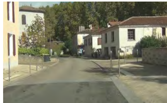
Source : Cerema Un plateau en enrobé beige a été créé à chaque intersection. Sur ces plateaux, les passages piétons sont suggérés.
