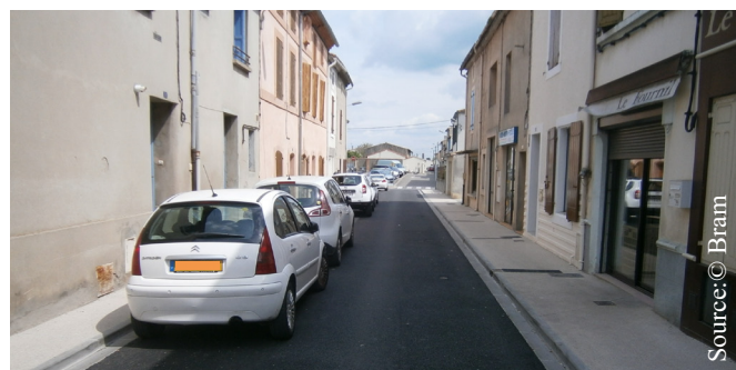
Une rue des faubourgs après travaux
