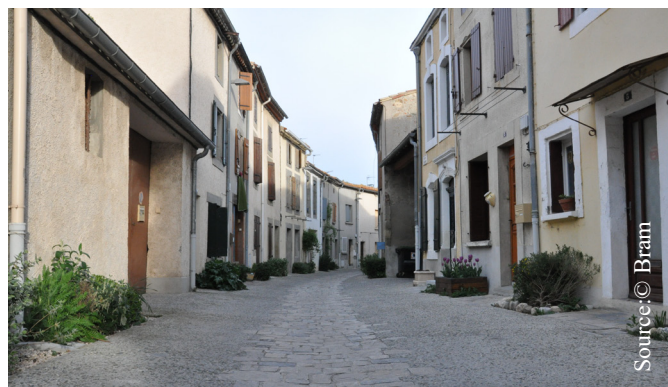
Requalification d'une rue du noyau historique: effacement des réseaux et rénovation des revêtements.
